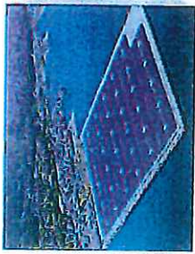
太陽光発電施設
